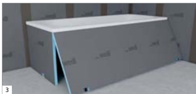
3 A kádszegély alatti elemeket helyezzük fel és igazítsuk be.
