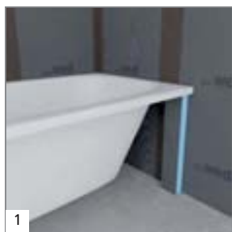
1 Ütközőrúd szerelése falra.
