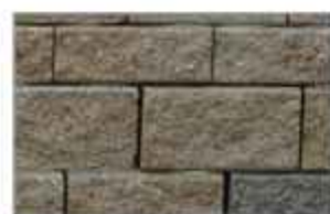
Kerítés hidrofobizált anyagból
