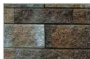
Kerítés hidrofobizálás nélkül
