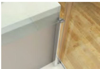
■ A rövidített oldalfal és a kád közötti csatlakozás részlete
