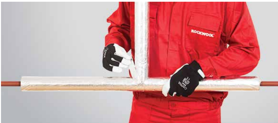
19. kép – Illesztések összeragasztása öntapadó alumínium szalaggal
