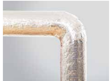
14. kép – Elkészült szigetelés PIPO ALS csőhéjjal
