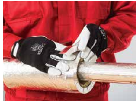
22. kép – A szigetelés lezárása alumínium szalaggal
