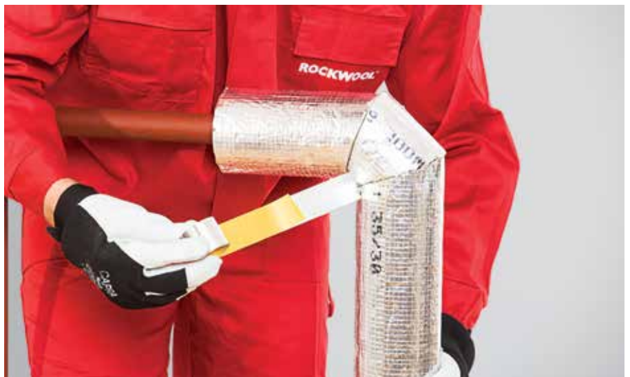
13. kép – Illesztések összeragasztása alumínium öntapadó szalaggal
