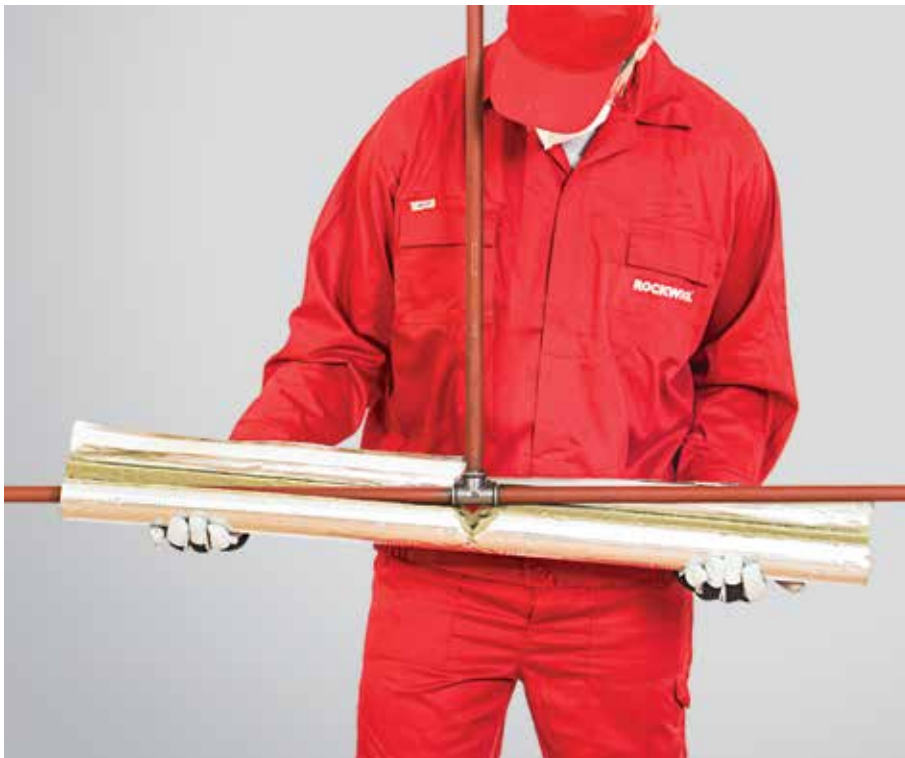
17. kép – Elemek felhelyezése a T elágazás száaira
