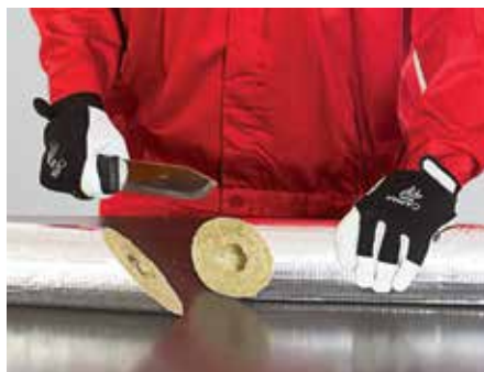
5. kép – A csőhéjat két 45°-os elemre vágjuk
