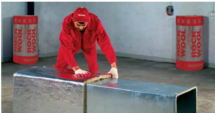
3. lépés – A szigetelés felragasztása
