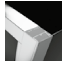
Ajtó profil csatlakozása az oldalfallal.
