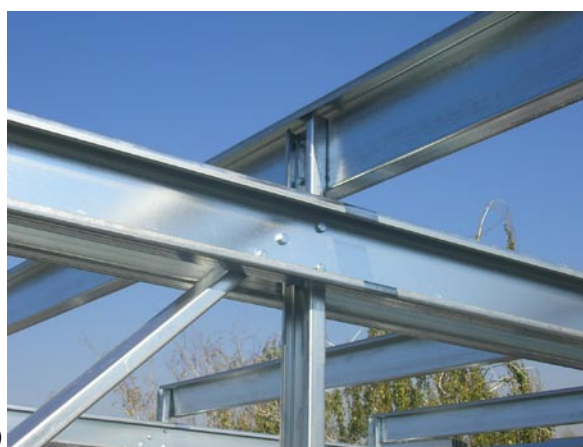
12. ábra. Megvalósult LindabTruss rácsostartós tetőszerkezet a) a tető komplett tartószerkezete; b) egymás után sorolt rácsostartók; c) egyedi háromtámaszú rácsostartó; d) előregyártott szerelési egységek deponálása beemeléshez; e) általános felső csomópont
