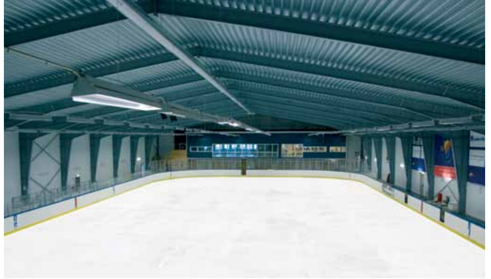
Épület: Műjégpálya csarnok, Svédország Alapterület: 2 500 m 2 Beépített Lindab anyagok: Lindab trapézlemez
