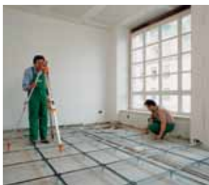
3- Puesta en cota de la estructura / Height adjustment of the structure and levelling
