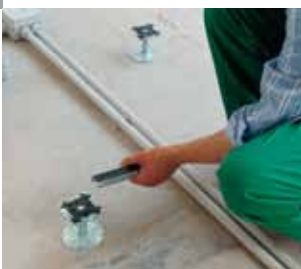
3- Puesta en cota de la estructura / Height adjustment of the structure and levelling
