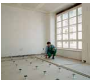
1- Posicionamiento de pedestales / Placing of pedestals
