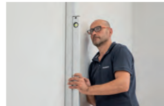
IT 1_ Prima di procedere con la posa verificare che il fondo sia perfettamente planare, asciutto e pulito. Utilizzare i collanti descritti miscelati in base alle specifiche indicate nella scheda tecnica del collante prescelto. Si raccomanda l'utilizzo di adesivi cementizi ad alte prestazioni in classe C2 o superiore. Si suggerisce l'utilizzo di adesivi a scivolamento verticale nullo (caratteristica identificata dalla lettera T).
