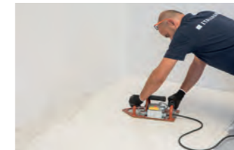
IT 6_ Con l'apposito battitore a vibrazione (o in alternativa con frattazzo in gomma antirimbazzo) assicurarsi che l'incollaggio della lastra avvenga in modo uniforme. Battere dal centro verso i bordi per favorire l'eliminazione di eventuali sacche d'aria tra la lastra, il collante e il fondo di posa. Non utilizzare martelli o utensili non idonei.
