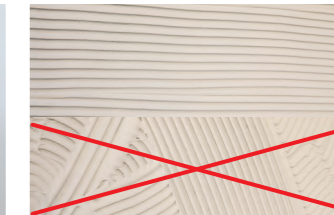
IT 3_ Una volta distribuito il collante accertarsi che nell'ultima stesura l'andamento delle righe sia sempre e solo in un unico verso (per una stesura a regola d'arte le righe dovrebbero essere in linea con il lato corto della lastra), evitare gli incroci che non favoriscono l'espulsione dell'aria dal centro della lastra.
