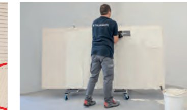
IT 4_ Stendere il collante sul retro della lastra utilizzando l'apposita spatola a denti quadrati (3x3 mm) e accertarsi che le righe dell'ultima stesura siano nella stessa direzione di quelle della spalmatura della lastra. Durante la fase di stesura, la lastra dovrà essere in posizione verticale e fissata al telaio di movimentazione con ventose di sicurezza posate sopra al carrello per il trasporto con ruote.
