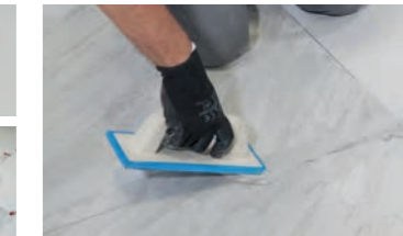
IT 8_ Si raccomanda di alternare e orientare i pezzi in modo da creare una distribuzione naturale del disegno e delle venature. Si consiglia una stuccatura in tinta con il prodotto, mantenendo una fuga minima di 2 mm (come prevede la normativa europea).
