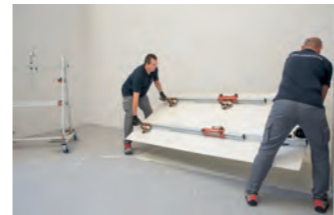
IT 5_ Mediante il telaio di movimentazione con ventose di sicurezza accompagnare la lastra in posizione e posarla.
