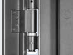
Az ajtólapon lévő pántgörgők egyszerű cseréje (a képen OD multifunkciós ajtó)
