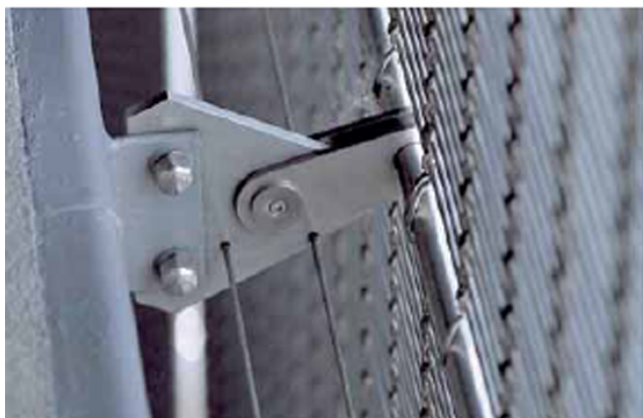
Középső rögzítés: Kerek rúd beépített, háromszög alakú konzolhoz csatlakoztatott függő rögzítő lemezekkel (Szövet típusa: MULTI-BARRETTE)
