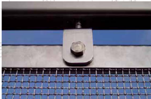
Felső rögzítés: feszítő profil és clevis csavar
