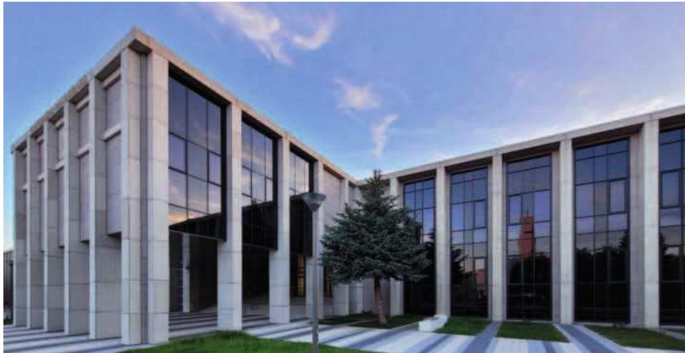
La modernización y ampliación del edificio principal de la Universidad de Rzeszów, que alberga el rectorado y el auditorio, fue **rehabilitado mediante fachada ventilada con láminas de Coverlam Arken**, una serie que simula el hormigón encofrado.
