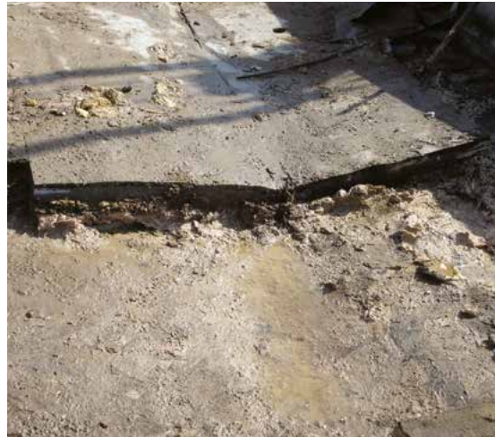
A tető felépítésében a kicsapódott nedvesség mennyisége óriási lehet
