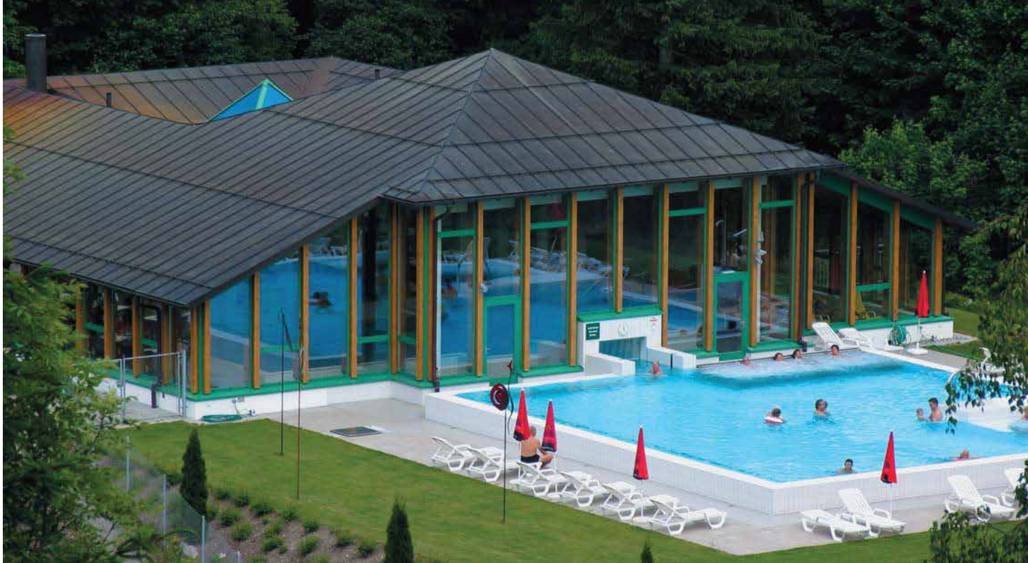
Rézlemez fedésű uszoda, Alvaneu, Svájc – Tervező: Martin Stöhr
