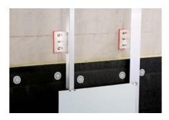
Keramik- oder Feinsteinfassaden werden am besten sichtbar mittels Edelstahlklammern befestigt. Weitere Systeme zur Befestigung von Terrakotta-Elementen und Glas-Platten mittels Aluminium- und Edelstahlklammern stehen selbstverständlich auch zur Auswahl.
