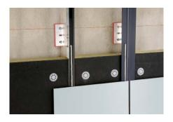
Mittels Klebetechnik können grossformatige Fassadenelemente auch verdeckt befestigt werden. Diese Technik ist geeignet für Platten aus Faserzement, Keramik, HPL und Aluminium-Verbund. Bei geklebten Fassadenplatten werden aufgrund der besseren Reinigungsmöglichkeit glatte Tragprofile verwendet.
