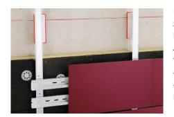
Fassadenplatten aus Keramik, Faserzement, Faserbeton, Naturstein und HPL können mit Agraffen auf horizontalem Agraffentragprofil verdeckt befestigt werden. Hilti bietet für die Montage auch zugelassene Hinterschnittanker an, abgestimmt auf die Art der Fassadenplatten.
