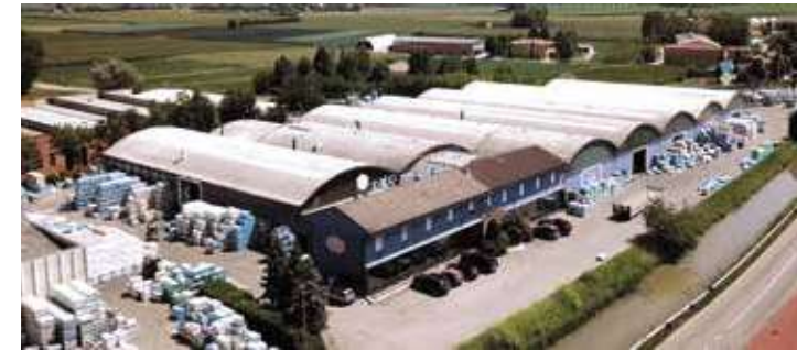
Dado Ceramica Uffici e Stabilimento Produttivo (Offices and Production Plant)
