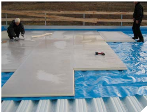
PE párazáró fólia fektetése a trapézlemezre
