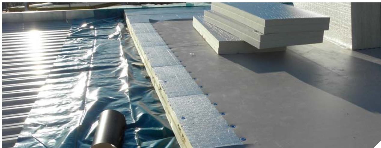
Tetőszigetelés és csapadékvíz szigetelés rögzítése
