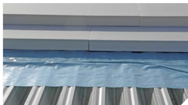
Fokozott hőszigetelés PIR táblákkal (2x14 cm)
