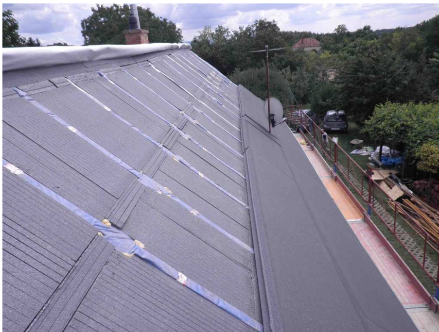
3. Sík felület kialakítása a szarufák között Klemmfix ® segítségével
