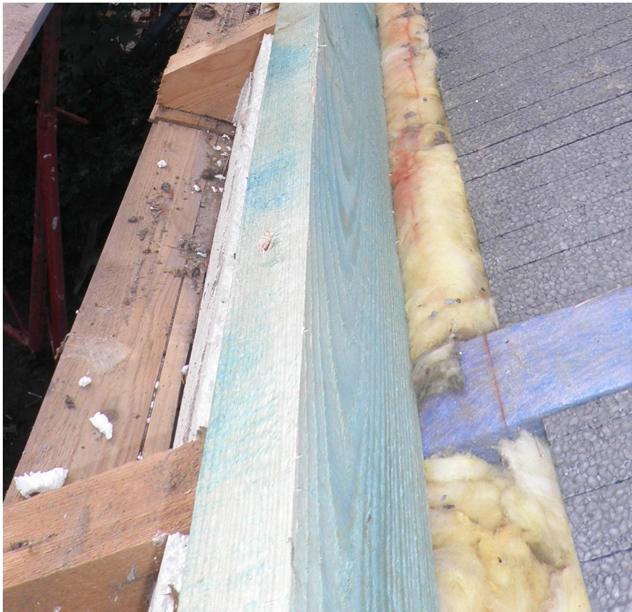
1. Az élpalló meggátolja a lecsúszást
