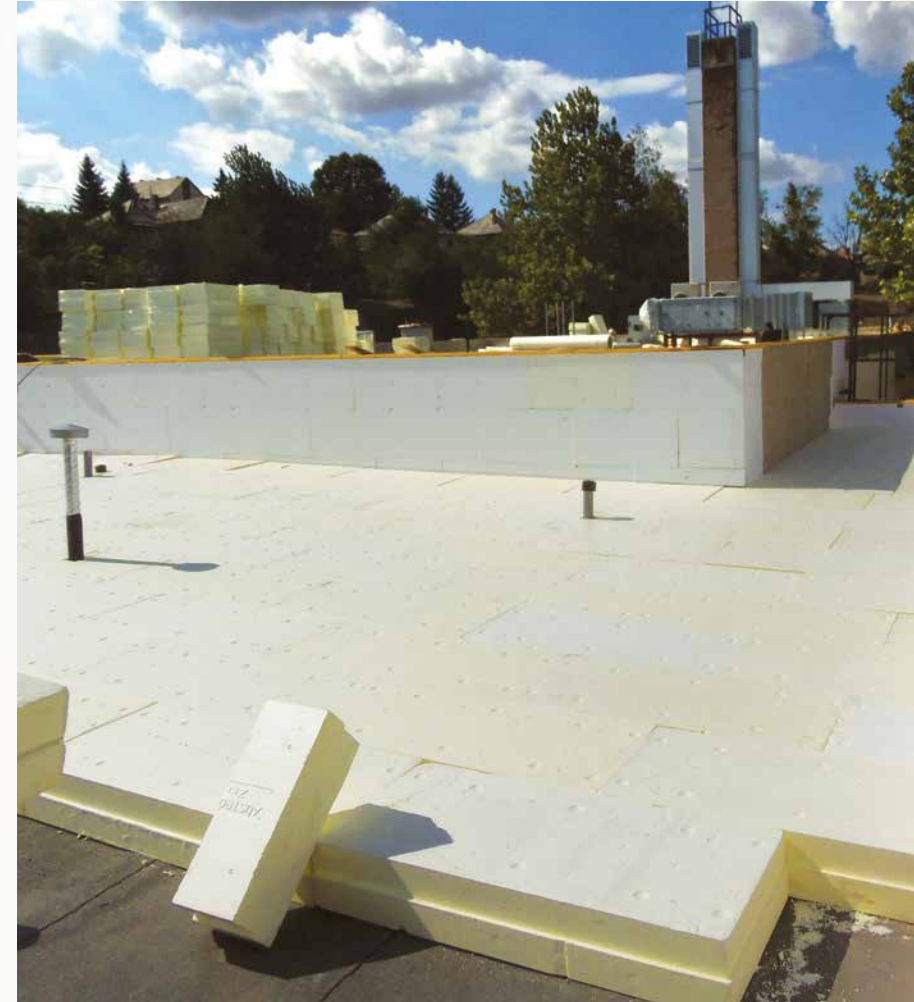
Kiegészítő hőszigetelés fordított rétegrendben fektetett Zenit® táblákkal
