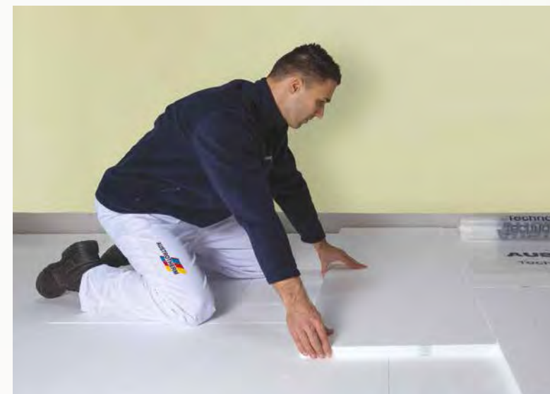
Lépéshang-szigetelés Austrotherm AT-L2 lemezzel
