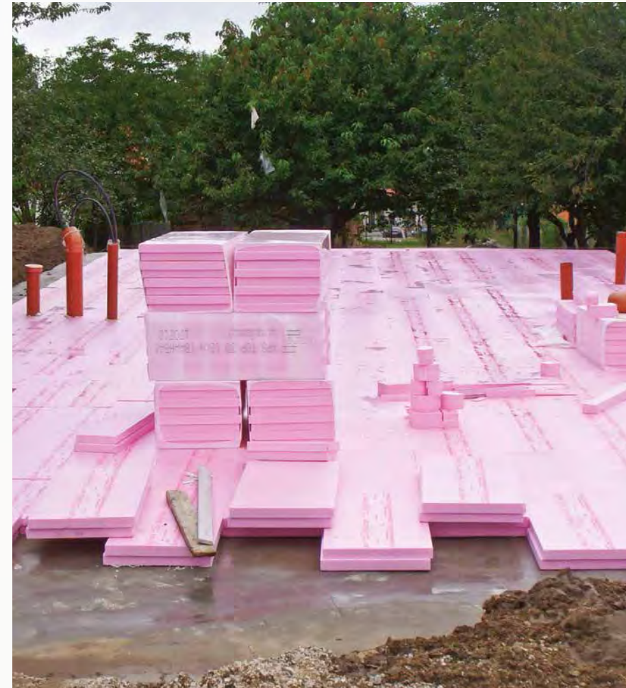
Passzívház alapjának hőszigetelése
