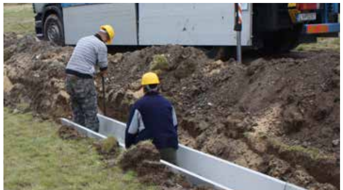
a szállítójárműről közvetlenül a munkárokba helyezhetők az elemek
