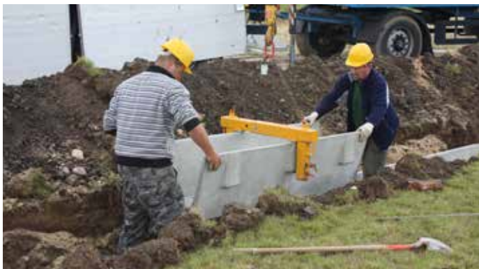
a speciális emelőszköznek köszönhetően, rendkívül hatékony az elemek beépítése
